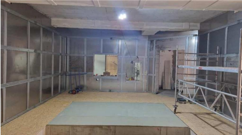
Einbau HF-Kabine im MRT-Raum mit Magnetfeldabschirmung. Die Befestigung der Abschirmung erfolgt an den Innenwänden. Hierdurch wird eine Flächenlast bis zu 2,7 t in die Wandkonstruktion eingetragen.
