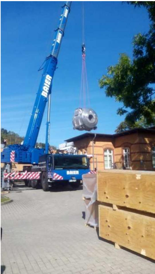
Für die Einbringung des neuen MRT wurde in der Fassade sowie in der Wandkonstruktion des MRT-Raums eine Einbringöffnung vorgesehen, welche nach Anlieferung verschlossen wurde.
